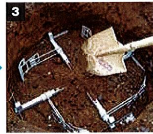
3 根鉢の位置を調整するための土を敷き均す。
