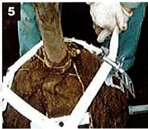
5 肩バットに、ベルトウインチ付幹巻きベルトを取り付け、ベルトを掛け回す。
