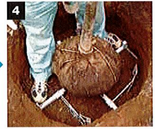
4 樹木の立ち、向きを調整しながら据える。
