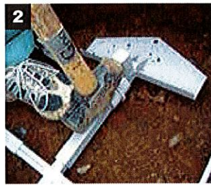
2 スライドアンカーを植穴の側壁に打ち込む。
